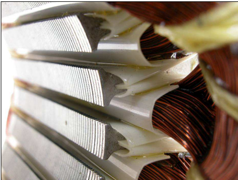
Abbildung 26: Weiße Kunststoffisolierung zwischen den Eisenkernen und den Spulen des Stators. Diese Kunststoffbänder könnten, einmal brüchig geworden, zu einem konservatorischen Problem führen.
